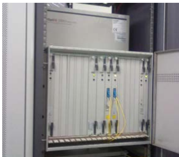
รูปที่ 6.35 ช่องสล็อตของอุปกรณ์ SDH สำหรับเสียบ SFP
