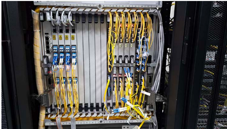
รูปที่ 6.37 ช่องสล็อตของหน้าโมดูลอุปกรณ์ DWDM สำหรับเสียบ SFP
