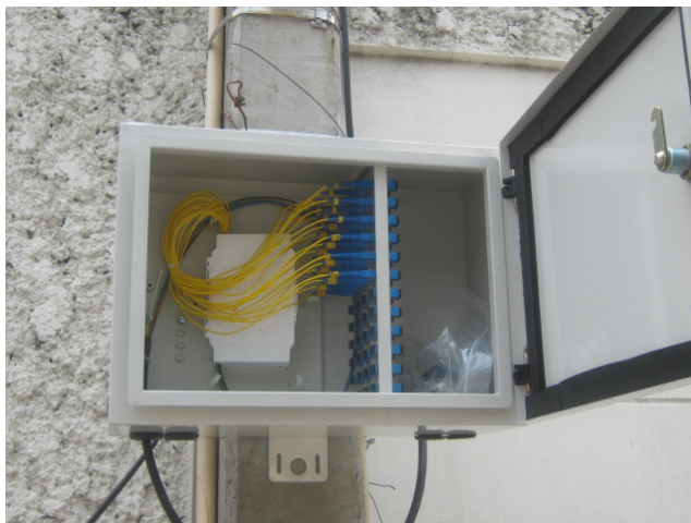
รูปที่ 6.10 การนำสายไฟเบอร์ออปติกที่ใช้ภายนอกมาเชื่อมต่อกับสาย Pigtail
